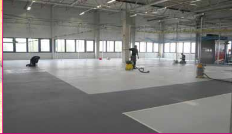
Auftragen des Allesprimers bei Miele
