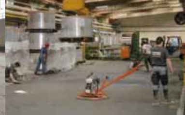
500 qm verlegter Rheobeton in Seesen
