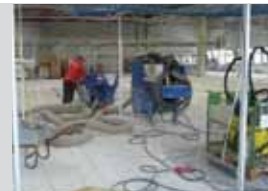
Freitag ab 14.00 Uhr Untergrundbehandlung durch Kugelstrahlen
