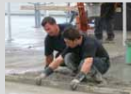
Samstag ab 6.00 Uhr Der Einbau des neuen Industriebodens beginnt.
