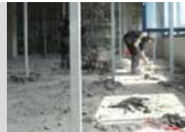
Donnerstag 14.00 Uhr Rückbau und Entsorgung des sanierungsbedürftigen Bodens.
