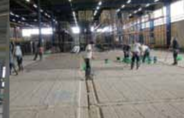
Auftragen des Allesprimers bei Miele
